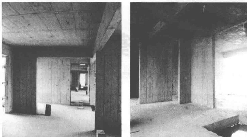
图 1-5 铝合金模板施工效果图
