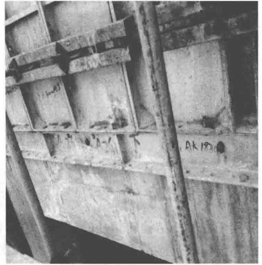
图 2-8 外墙板与 K 板连接
