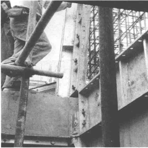
图 2-7 K 板上安装墙模板
