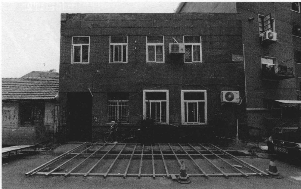
在滨县路上看滨县路2号的南立面
