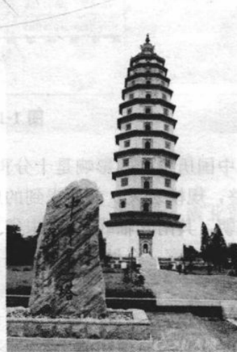
图 1-15 河北定县开元寺料敌塔
