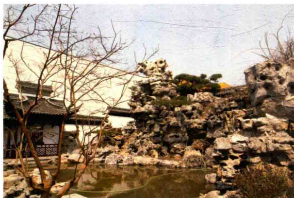
图 15 片石山房施工
