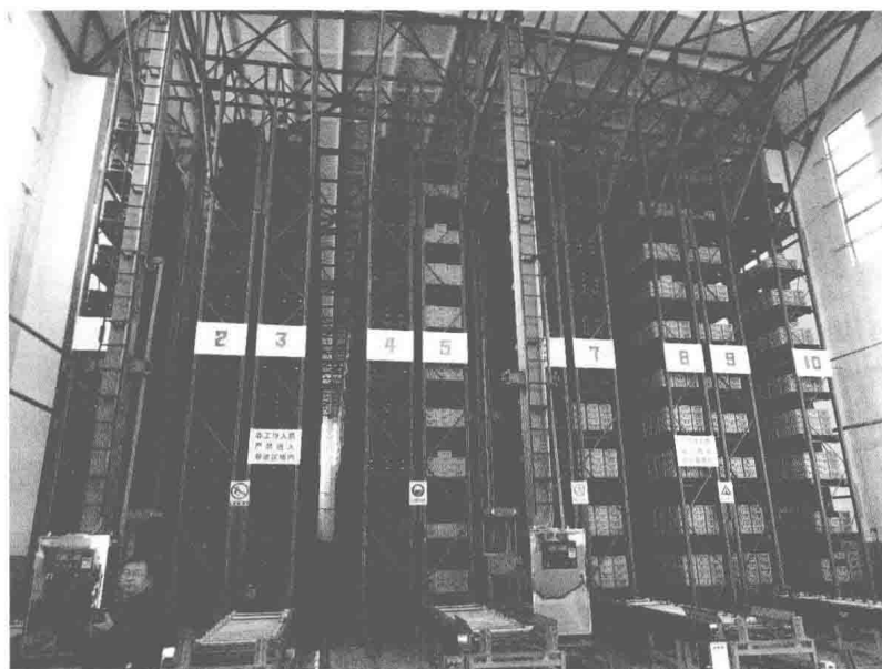
图 1.4 吐哈油田岩心库的立体仓储设施
