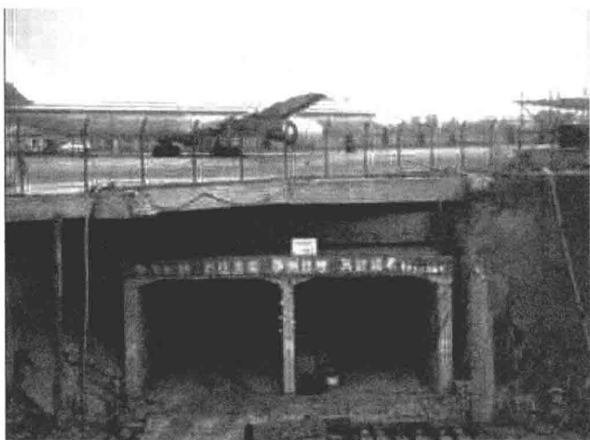
图 1.5 箱涵顶进施工现场
