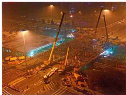
2015 年 11 月 14 日凌晨，三元桥改造工程现场
