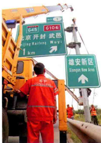
衡德故城支线更换雄安新区指示标牌
