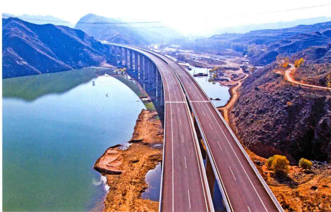
忻保高速公路米家寨大桥
