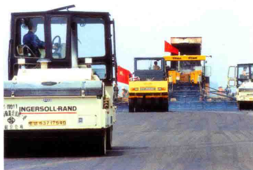
现代化路面施工
