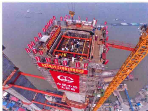
五峰山长江大桥主跨 1092 米，是世界荷载最大的公铁两用悬索桥，计划 2020 年 8 月通车
