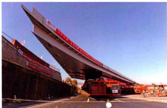
昌平西关环岛桥梁改造工程成功实施“千吨级驮运架一体机”2号桥新梁整体运架新工法
