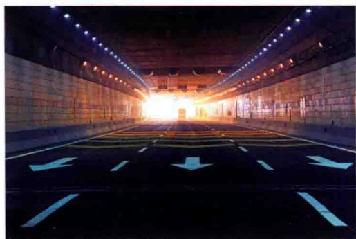
世界直径最大的盾构隧道——钱江通道
