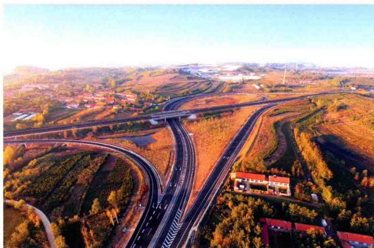
鹤大高速公路前阳互通立交
