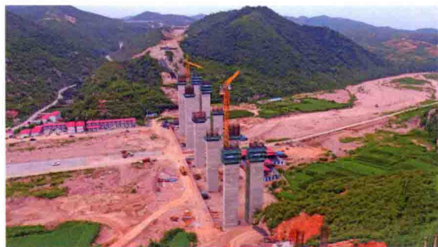
太行山邯郸段大桥建设场景
