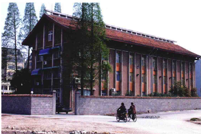
■ 1984年10月在县政府大院内建成的1269平方米的档案馆大楼
