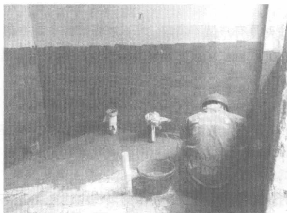
图1-1 墙地面防水涂料刷过程
