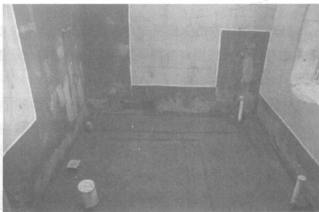
图1-2 防水涂料刷完工
