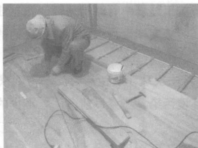
图1-4 实木地板安装
