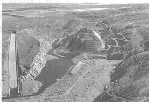
图 1.5 Teton 大坝溃坝现场
