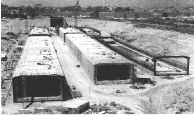
图 1-1 整体式管节
