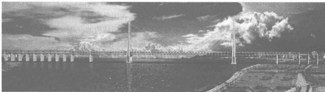
图 1-3 武汉天兴洲长江大桥
