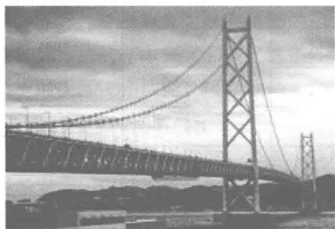
图 1-10 明石海峡大桥
