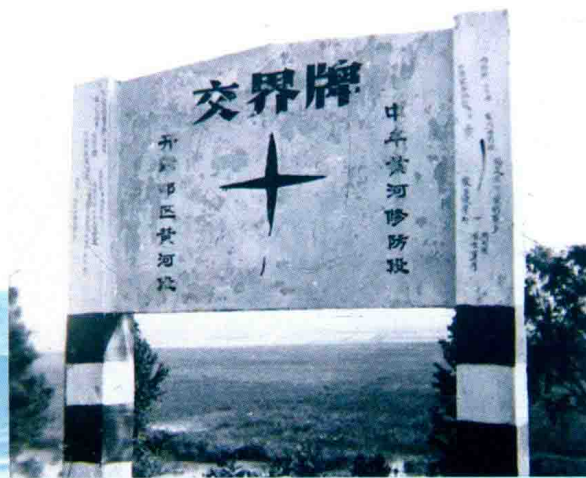
郑州、开封黄河交界牌 (堤防 千米桩号 70+250) (2002年)
