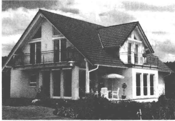
图 0.2.1-4 轻型木结构住宅
