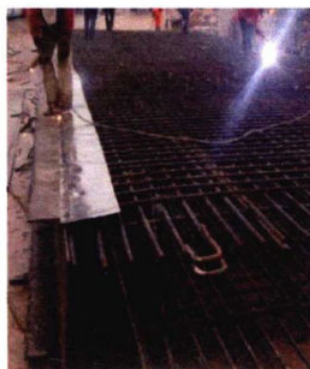
图 1.1.4-5 接头焊铁皮
