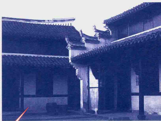
萧山长河老建筑慎俭堂
