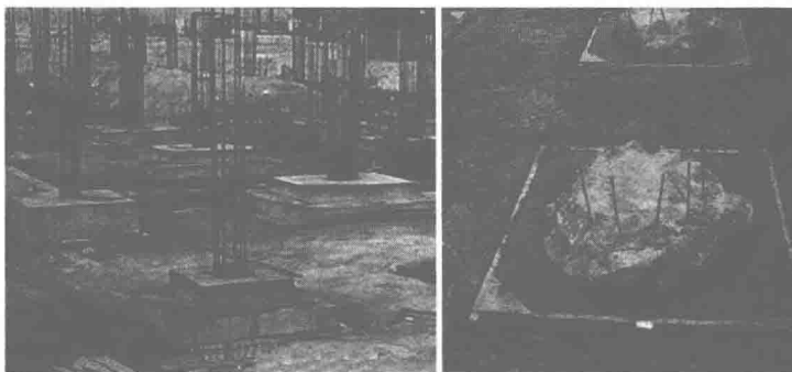
(a) 浅基础: 柱下单独基础
