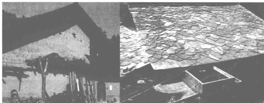
(a) 土墙房屋
