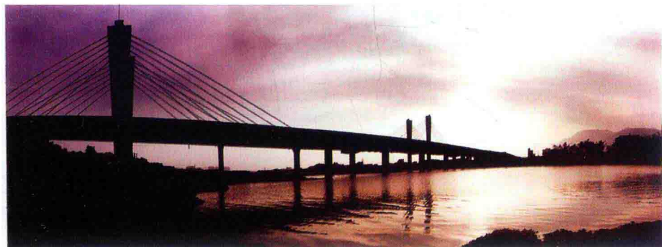
建设中的仙游大桥
