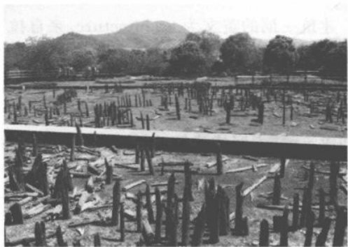
图 1.2 河姆渡干栏式建筑遗址
