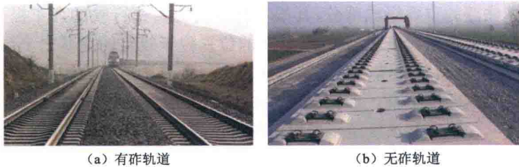
图 1-2 铁路轨道结构
