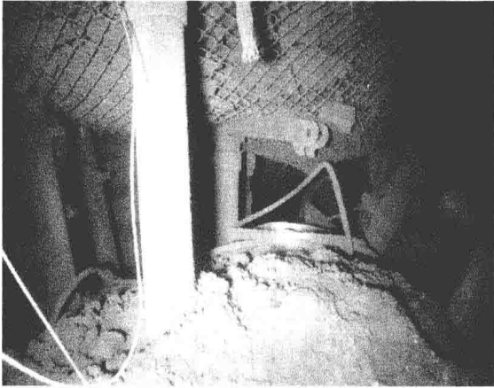
图1-5 临空巷道超前变形严重
