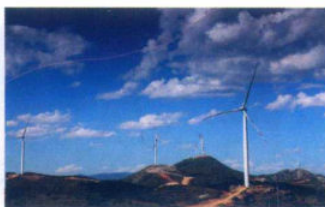
交口棋盘山风电场项目（100MW）
