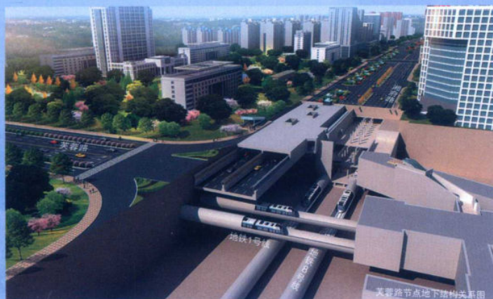
湘府路快速化改造
