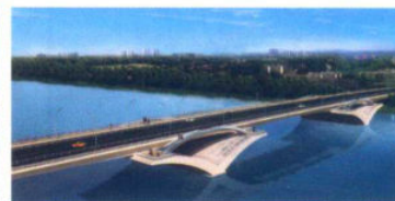
衢州市书院大桥（单跨 150m）
