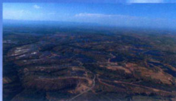
包头领跑者 50MW 光伏项目
