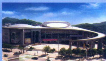
贵阳大剧院(获“鲁班奖”) 贵州三维监理咨询公司监理
