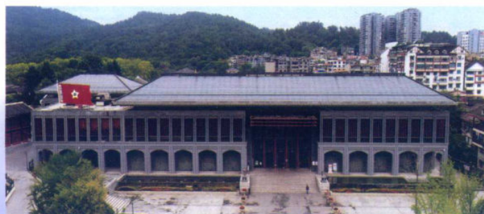
遵义会议陈列馆(获“国家优质工程奖”) 贵州建工监理咨询公司监理
