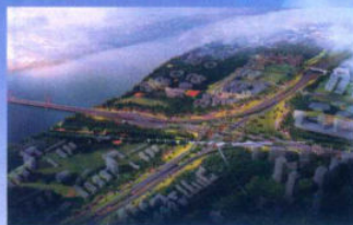
杭州之浦路立交桥
