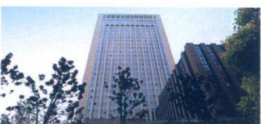
鲁班奖——省特种设备安全监督检查与操作培训实验基地工程
