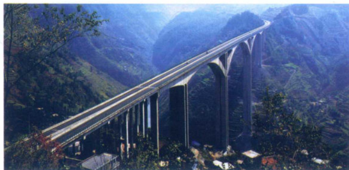
水盘高速北盘江特大桥(获“鲁班奖”“李春奖”“詹天佑奖”) 贵州交通监理公司监理
