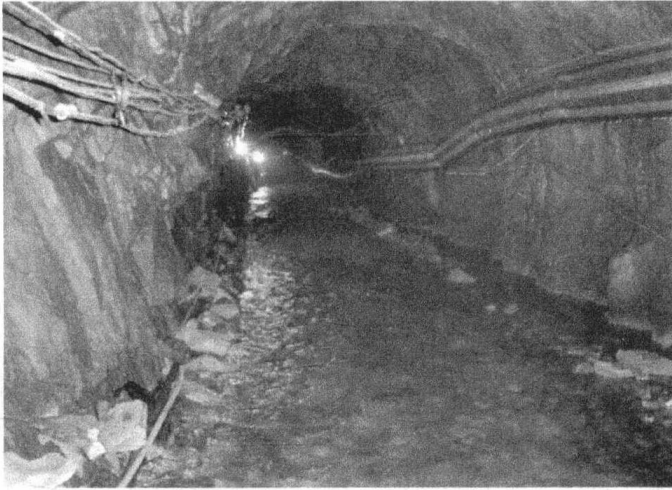
图 1-6 地下空间构筑过程中复杂的施工环境
