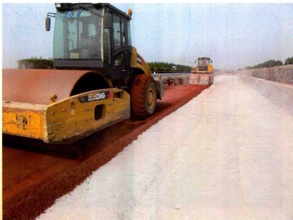
赤泥路拌路基施工
