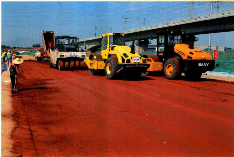
赤泥厂拌基层施工
