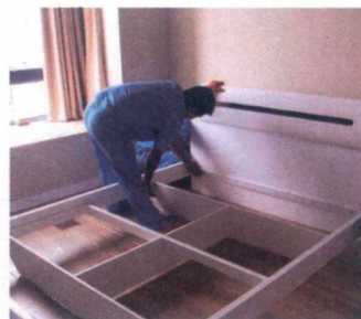
家具进场安装
