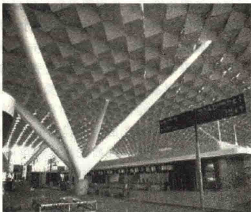
图 1-6 郑州新郑国际机场 T2 航站楼
