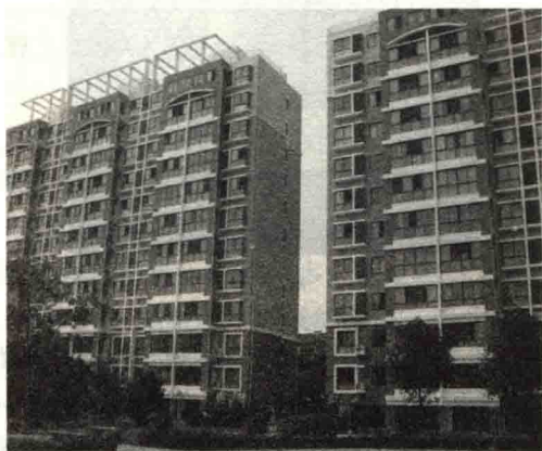
图 1-3 钢结构小高层住宅
