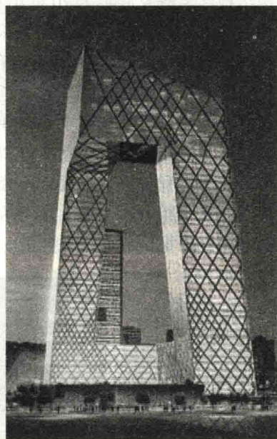
图 1-2 北京央视大楼
