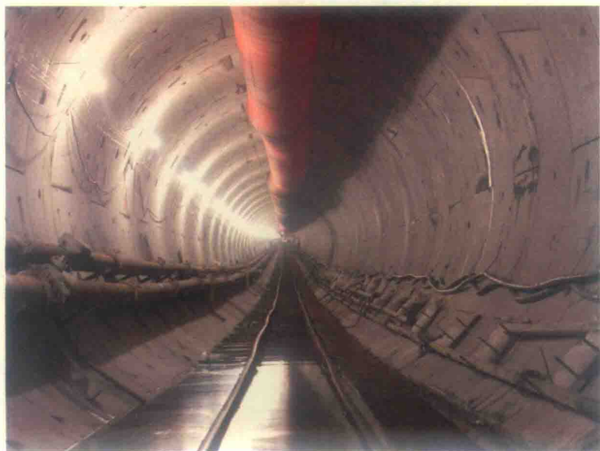
图 1-3 已贯通的盾构隧道
