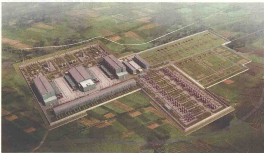
图 1.2-1 与交流特高压站相邻而建的南京换流站
