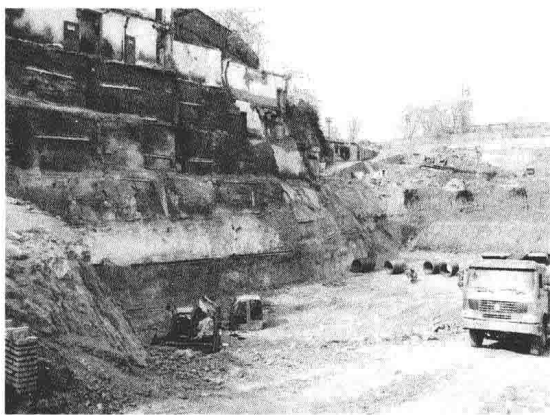
图1-3 项目B护坡照片
