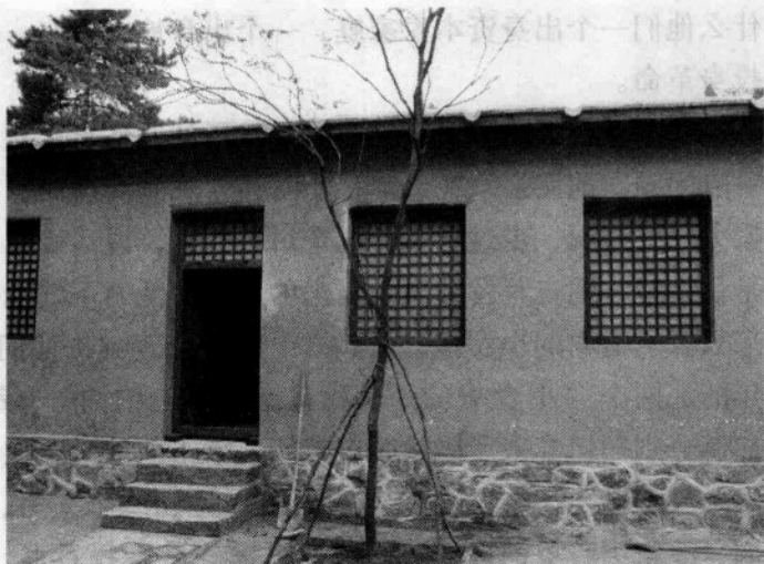
修复后的西柏坡新华社旧址。（新华社稿）
