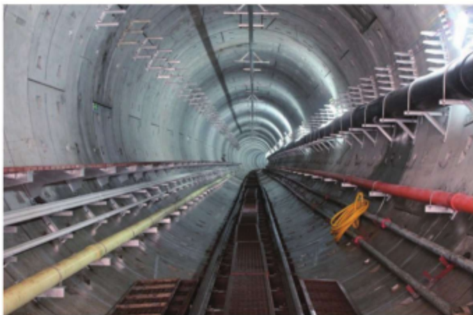
深圳地铁 9 号线创新使用预埋滑槽技术
