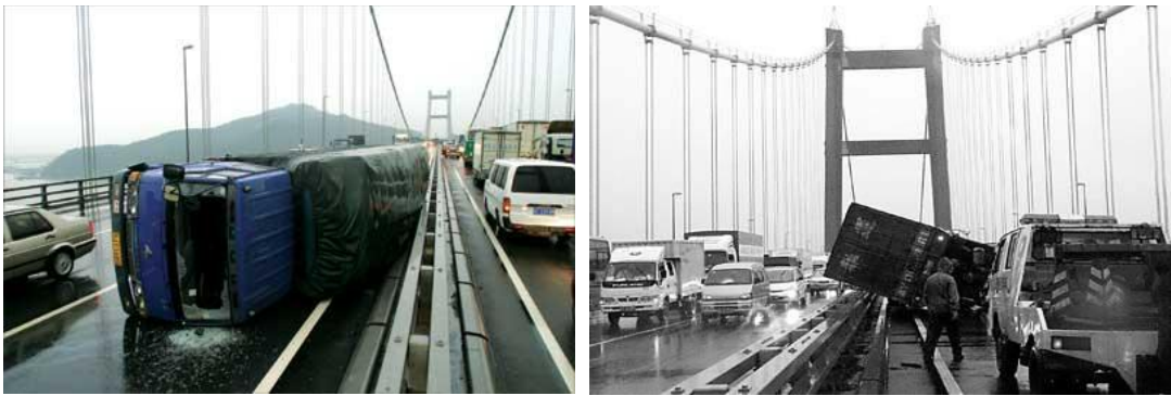
图 1.1 虎门大桥风致行车安全事故
