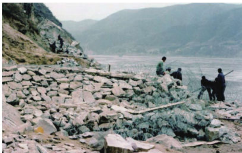
1995年5月， 黄河石屏至禹门口 河道整治工程11号 坝体铅丝网抛石作业
