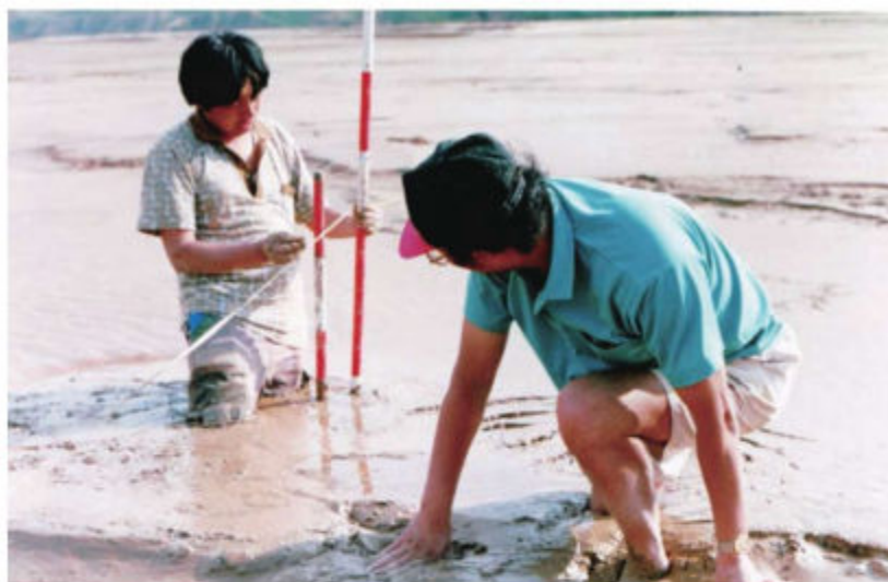
1994年7月， 工程技术人员进行黄河 石屏至禹门口段航 道整治工程测量作业
