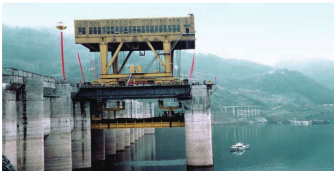
2002年8月建成并交付使用的汉江安康水电站100吨级干运垂直升船机，时为全省内河首座通航建筑物
