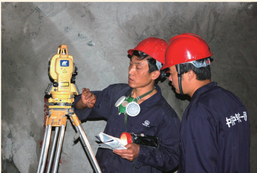
中铁一局技术人员在隧道内进行精确测量。（何海摄）
