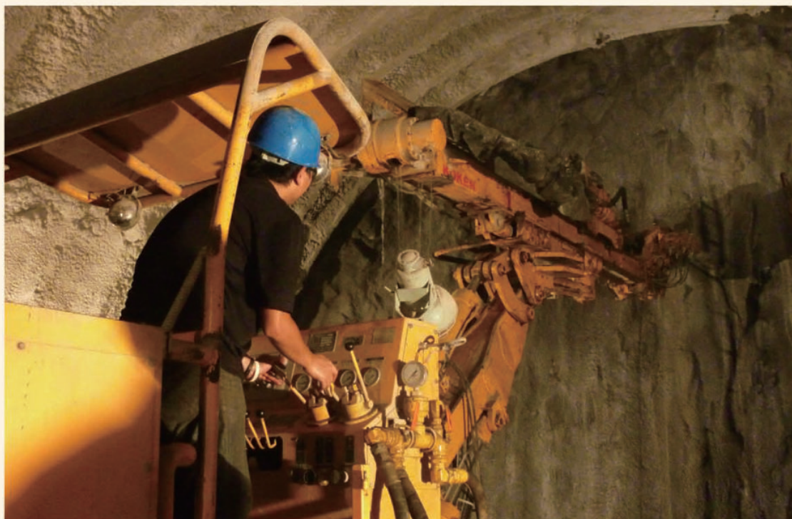
中铁二十三局技术人员在青山山隧道进行超前地质钻探工作。（林春华 摄）
