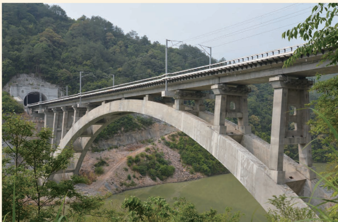
向莆铁路尤溪桥全景。（林春华 摄）
