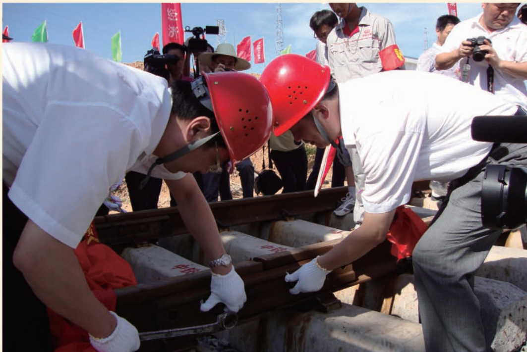
三明市副市长王刚（右）、向莆铁路公司总经理王建盛（左）为最后一节轨排合拢拧紧螺栓。（徐进摄）
