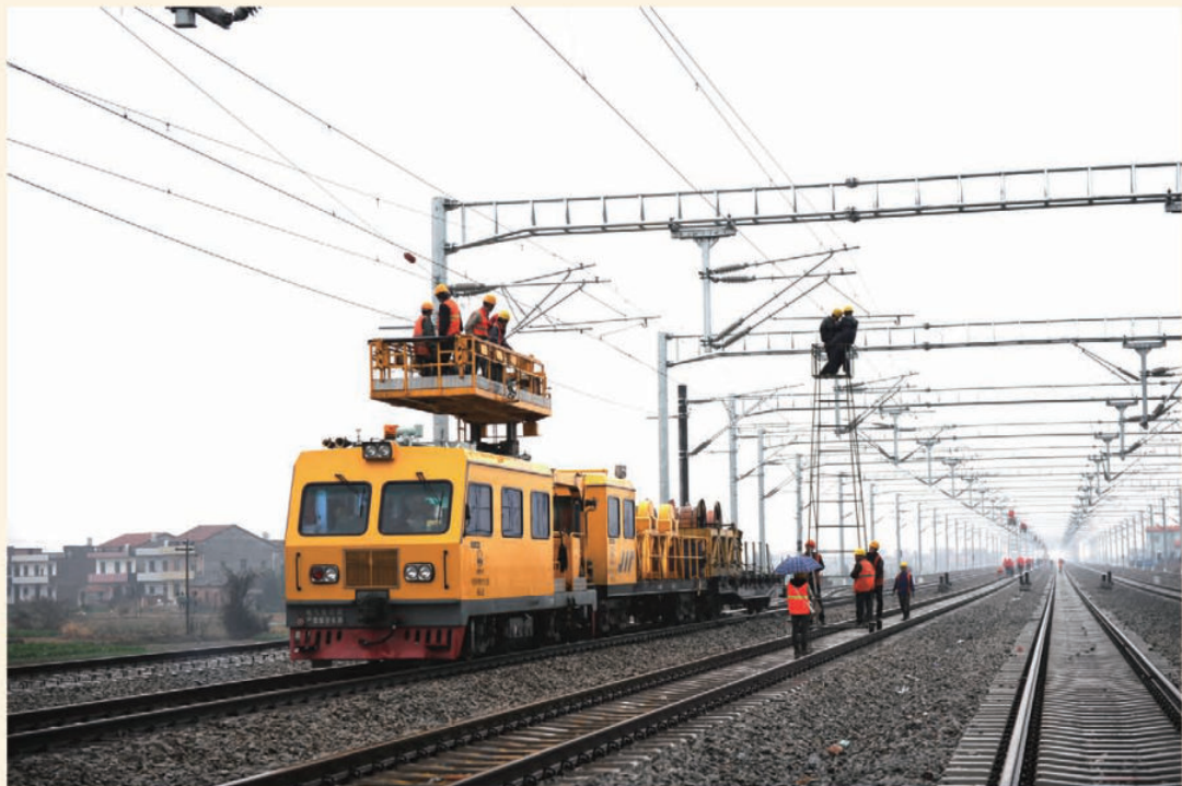
2010年12月13日，施工人员在雨中调整三江镇线路接触网。（陈亮摄）
