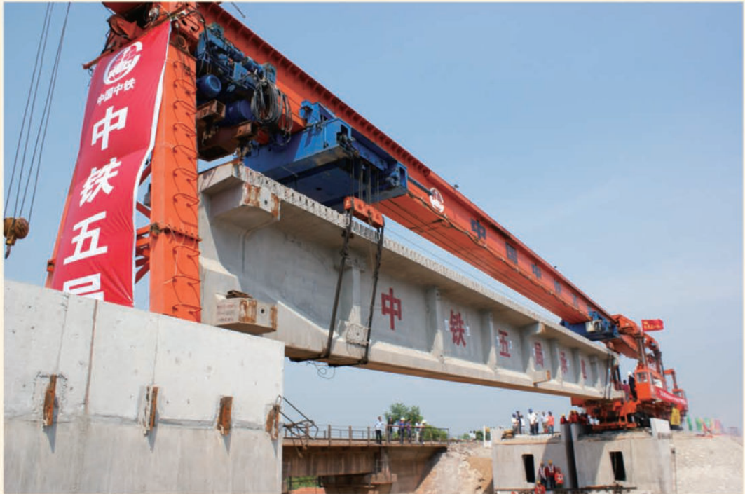
中铁五局在向莆铁路进行T梁架设。（徐进摄）
