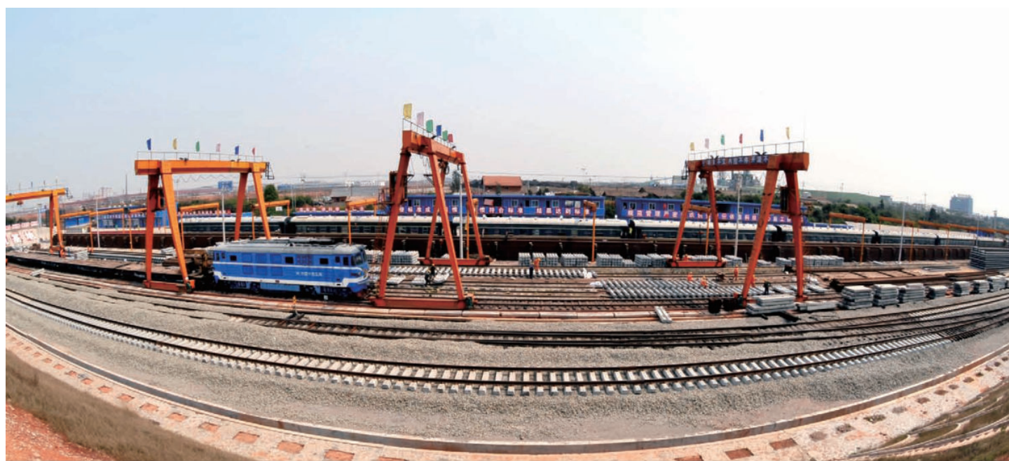
抚州铺架基地全景。（徐进 摄）
