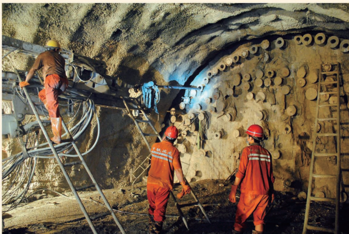
中铁二局大型机械设备在高盖山大隧道进行帷幕注浆时的情景。（张贵铎 摄）
