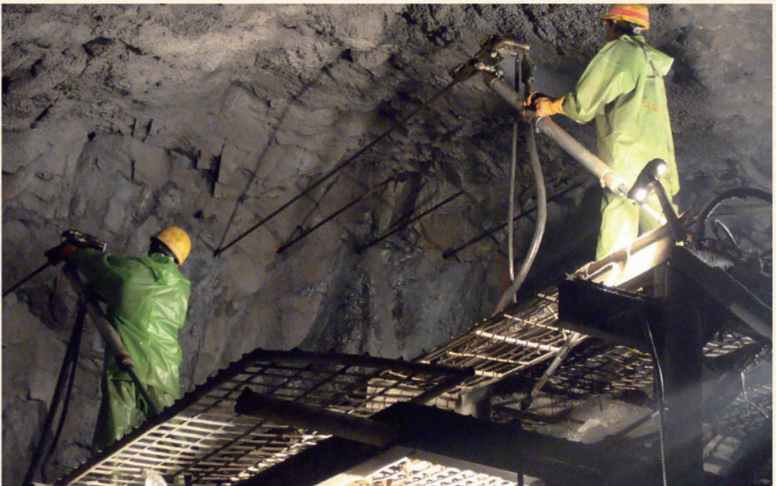
中铁二十三局在青云山隧道进行风枪打眼作业。（苟剑南摄）
