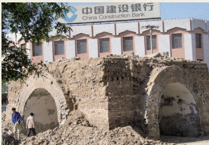
◆ 拆卸中的台基
