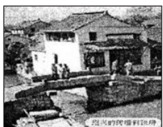
浙江绍兴的斜顶房 A
