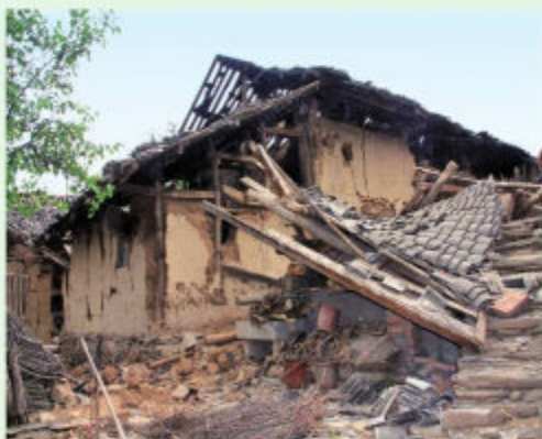
汉中市略阳县徐家坪镇徐家坪村土木结构房屋损毁严重(2008年5月13日摄)
