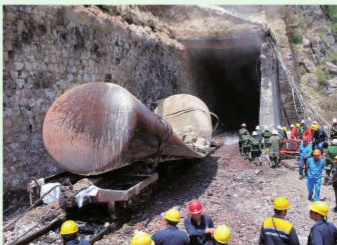
宝（鸡）成（都）线 山体塌方被压变形的油罐 车堵塞隧道（2008年5月19 日摄）
