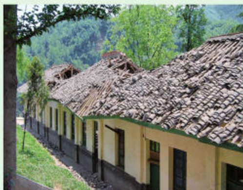
汉中市宁强县毛坝河镇初级中学砖木结构的校舍严重破坏（2008年5月16日摄）
