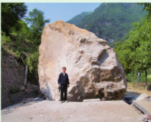
汉中市略阳县白石沟乡道路被滚落巨石损坏(2008年5月14日摄)
