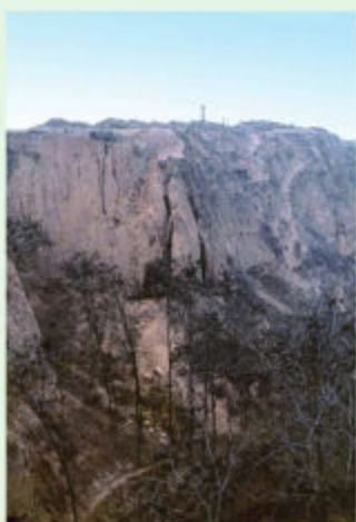
咸阳市泾阳县高庄乡 金田峪黄土边坡震裂滑塌
