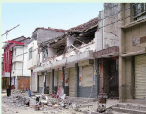
汉中市宁强县广坪镇砖木结构房屋严重受损（2008年5月13日摄）
