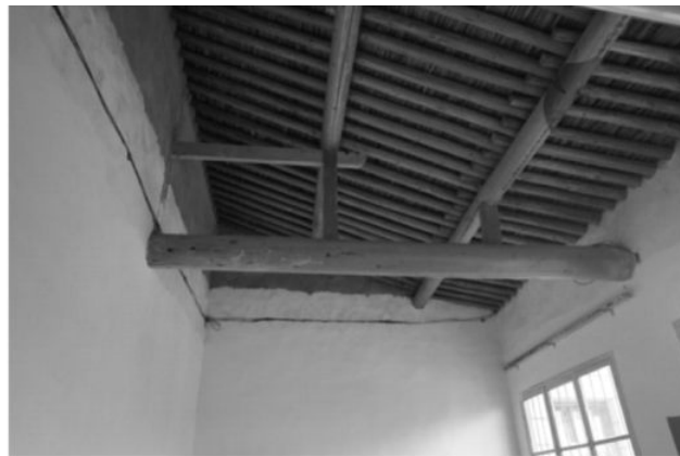
(b) 抬梁式屋面结构 (单坡)
