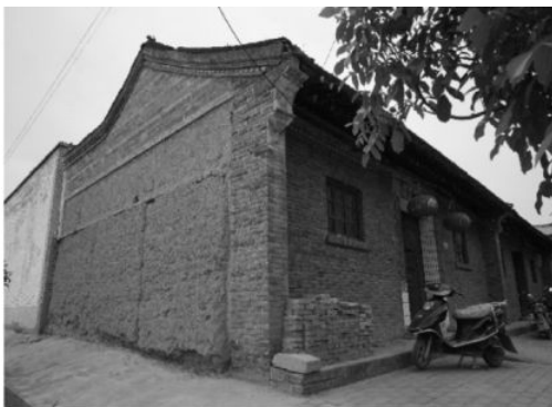
(b) “前砖后土”混杂结构
