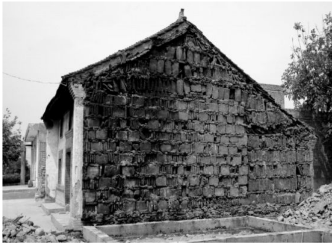
(a) 土坯墙承重结构
