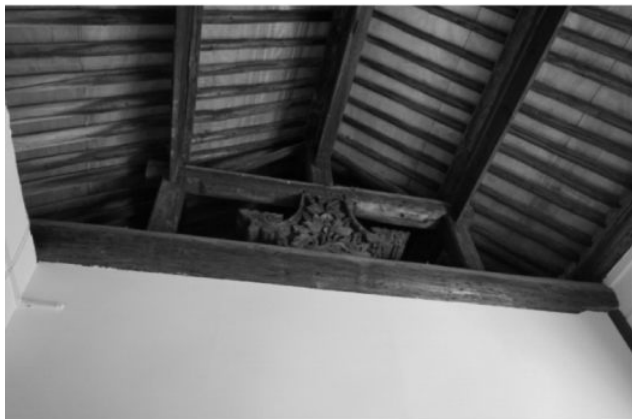
(a) 抬梁式屋面结构 (双坡)
