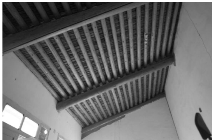
(f) 单根斜梁屋面结构 (单坡)
