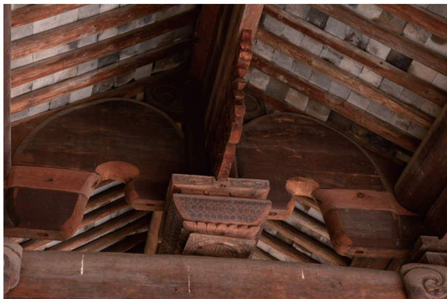
正殿二层主梁细部
