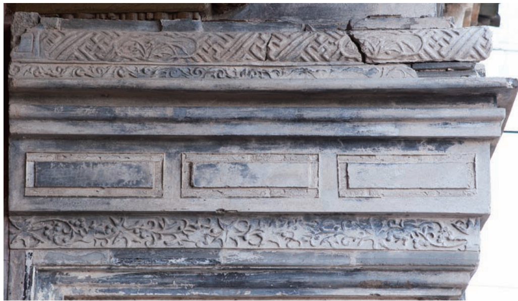
门廊北侧八字墙上部砖雕
