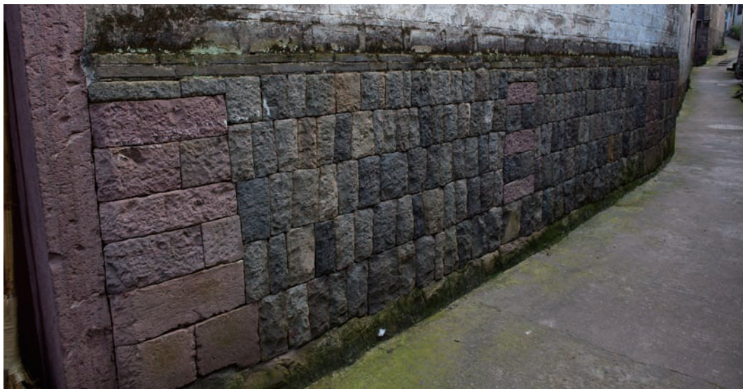
北侧立面石砌墙基
