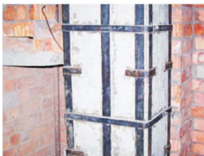
图1-49 加固立柱结构
