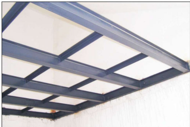
图1-38 型钢结构焊接楼板
