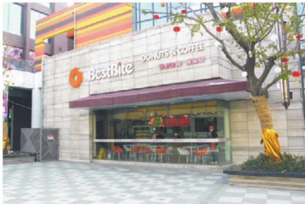
图1-17 店面外墙装修
