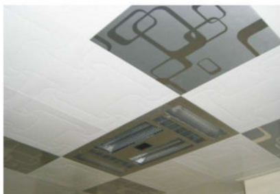
图1-11 金属扣板吊顶
