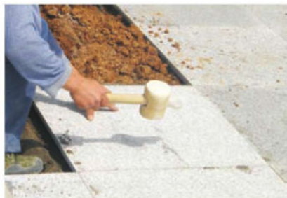
图1-34 石材铺装施工
