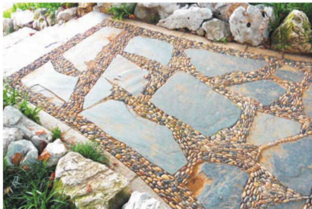
图1-16 庭院地面铺装
