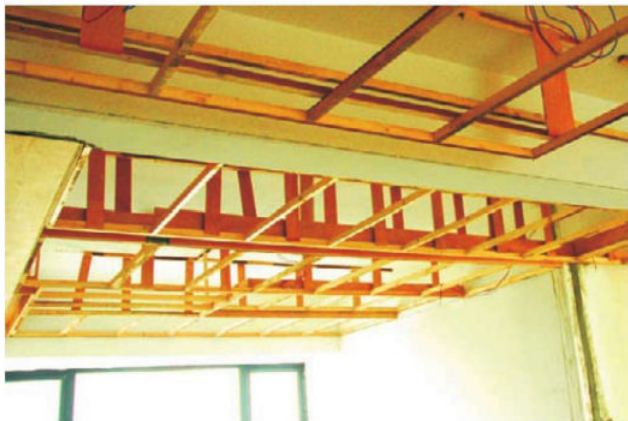
图1-47 吊顶基础构造
