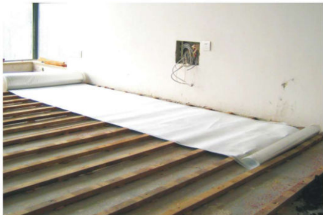
图1-39 木地板龙骨上铺装防潮毡
