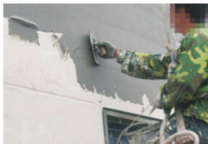
图1-35 外墙抹灰施工
