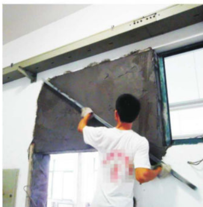
图1-40 内墙抹灰找平
