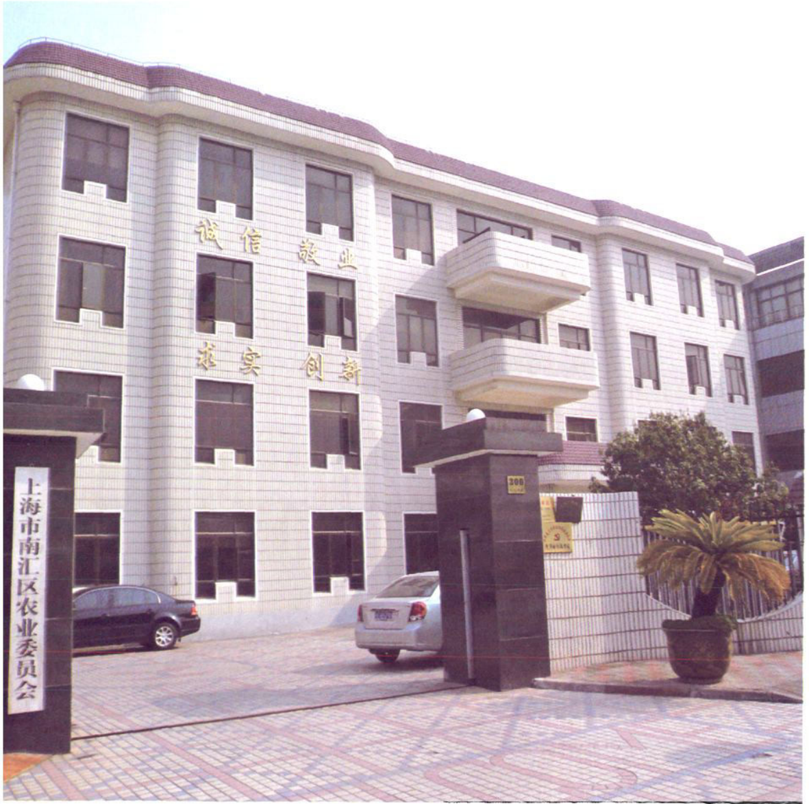
上海市南汇区农业委员会办公楼
