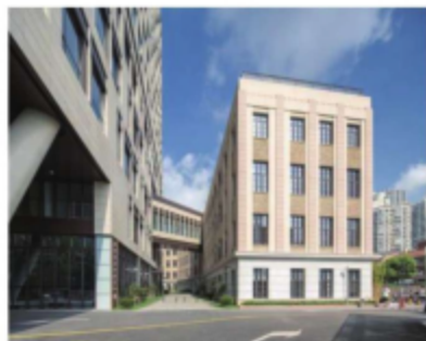
图 9 东侧(干保、IMCC、行政)出入口
