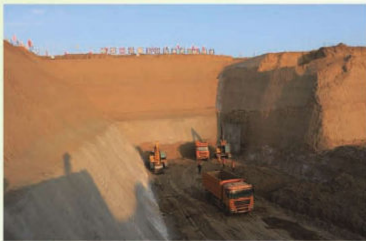
建设中的团结隧道
