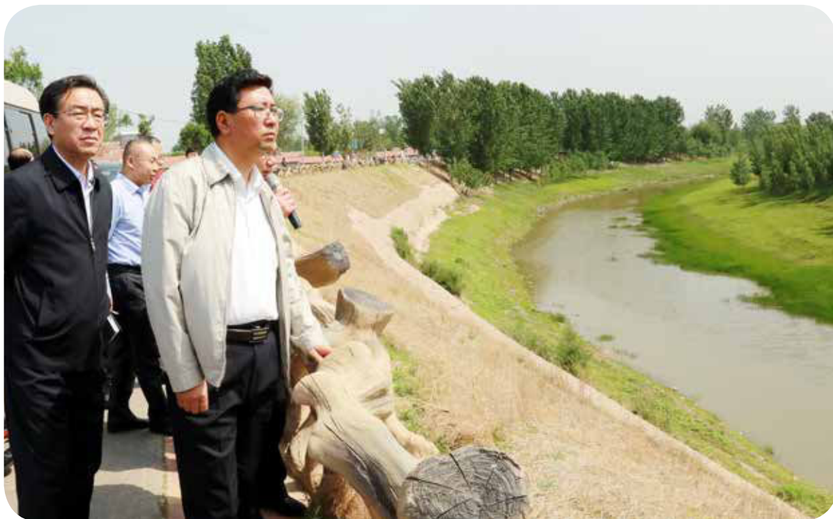
2018年5月8日，中共衡水市委书记王景武就大运河文化带建设在景县华家口夯土险工调研
