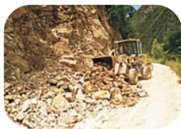
前缘不断发生掉块、坠落、小崩小塌的现象
