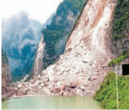
2008年“5·12”地震引发宝成铁路109隧道崩塌
