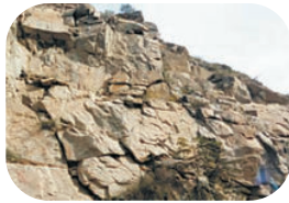
坡面出现新的破裂变形,甚至小面积土石剥落
