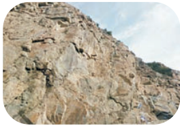
坡面出现新的破裂变形,甚至小面积土石剥落
