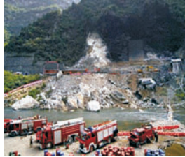
2008年“5·12”地震引发宝成铁路109隧道崩塌
