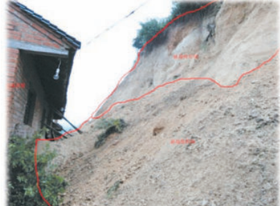
开挖坡脚发生掉块或崩塌应立即撤离
