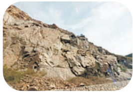
坡面出现新的破裂变形,甚至小面积土石剥落
