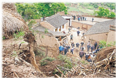
秦安县陇城镇赵山组崩塌
