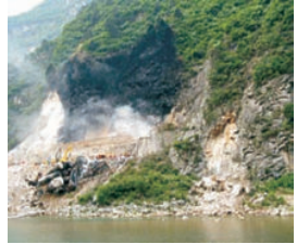
2008年“5·12”地震引发宝成铁路109隧道崩塌
