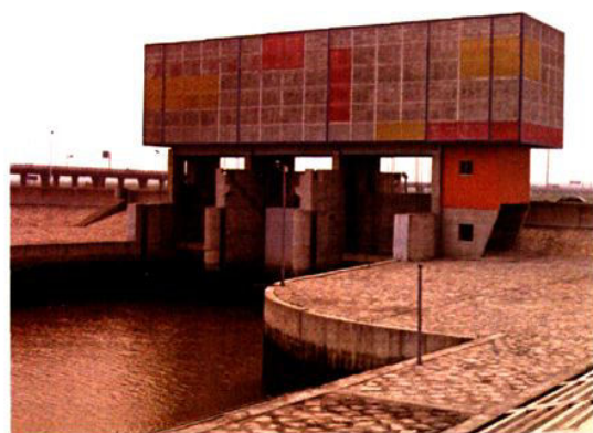
芦潮引河水闸
