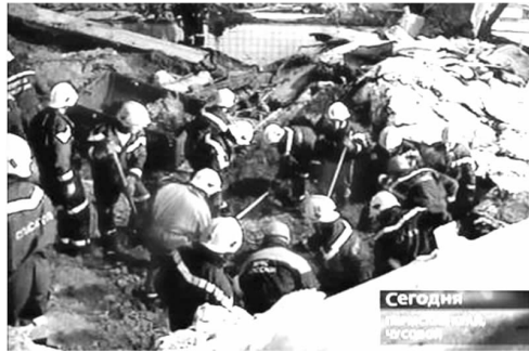
(b)莫斯科水上乐园屋顶倒塌
