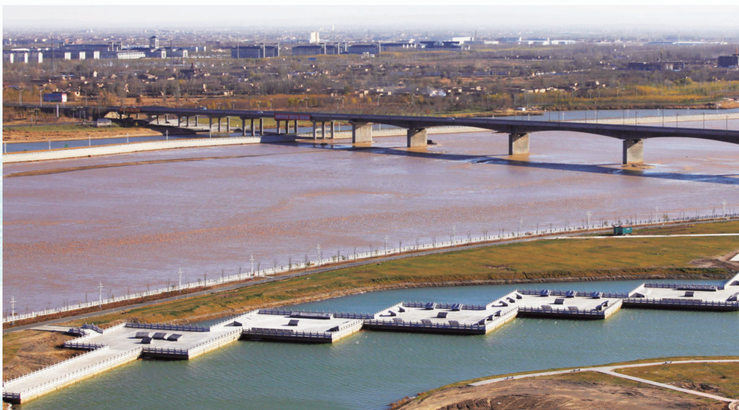
青铜峡黄河大桥
