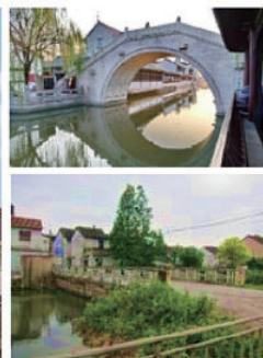
报恩桥(上) 摇铃桥(下)
