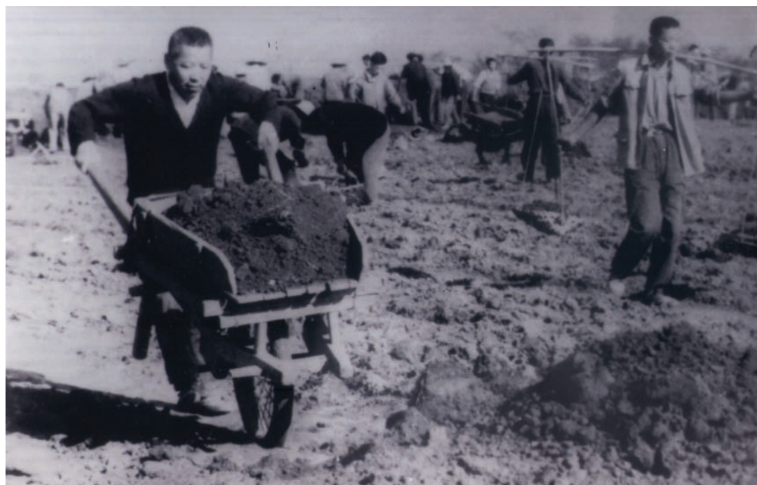
在柳门泵站工地参加劳动
