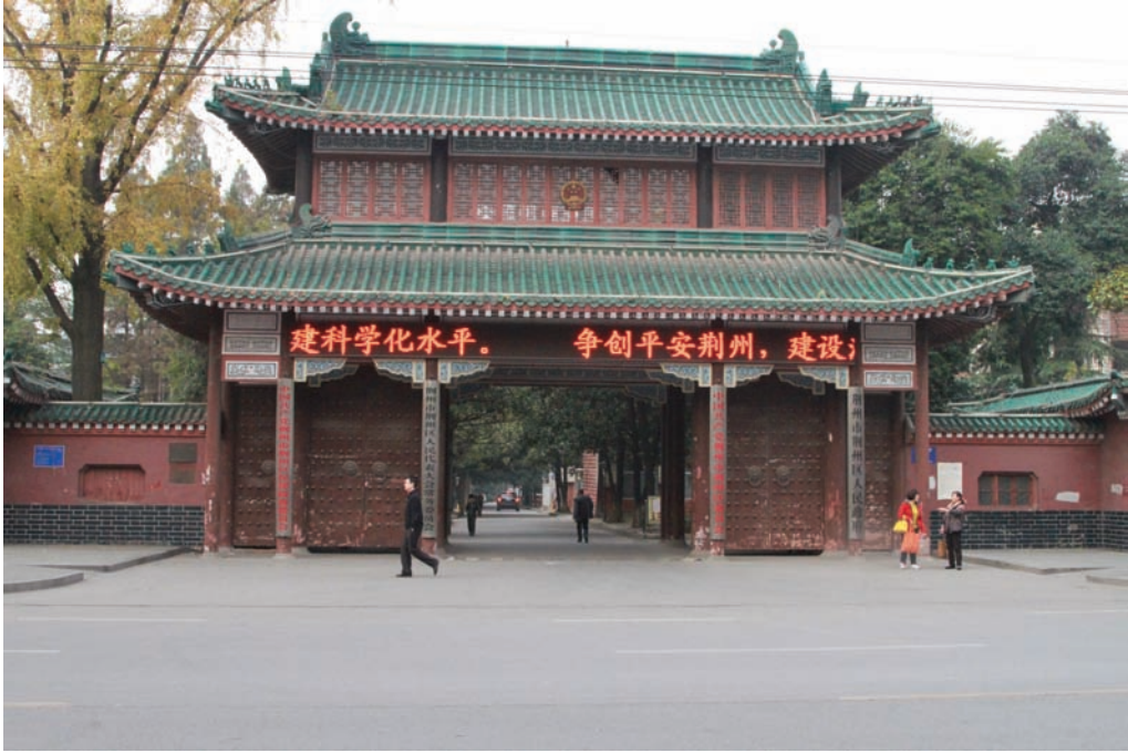
荆州区政府南大门门楼
